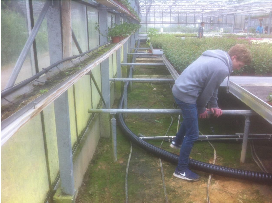
Die Verlegung der Fernleitung i, Gewächshaus
