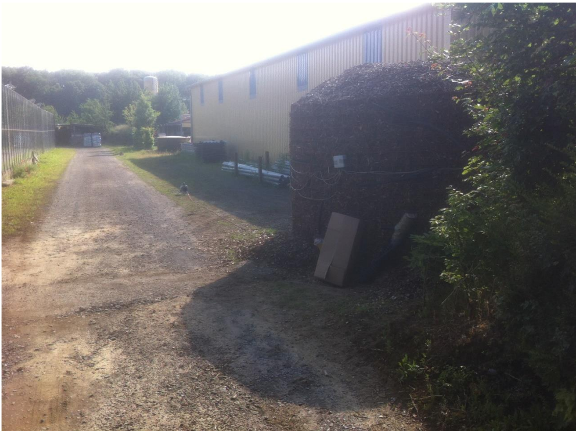
Nachdem Probetrieb kann die Anlage erweitert werden. Da passen noch einige Biomeiler hin
