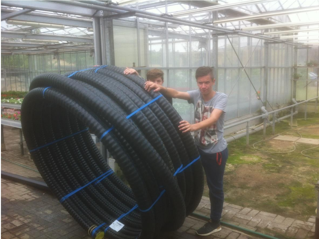
Die Rohrleitung verbindet den Biomeiler mit einem 1000 Liter Speicher
