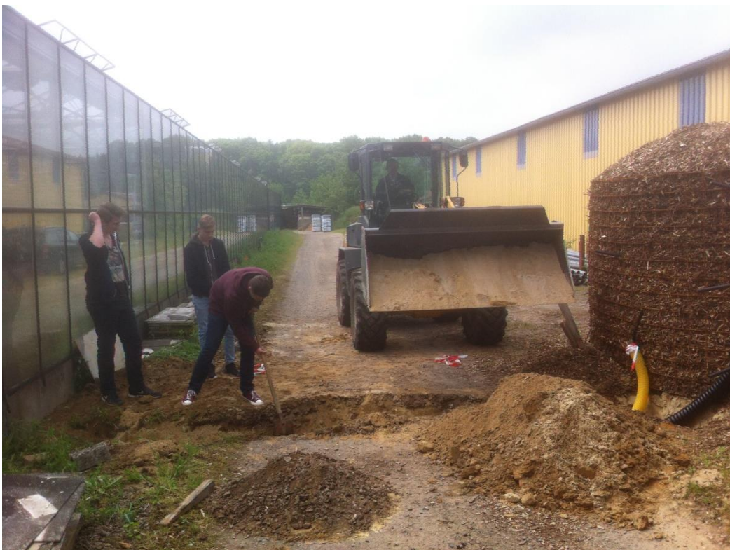
Der Anschluss zum Biomeiler wird hergestellt. Der Bauhof unterstützte uns kräftig
