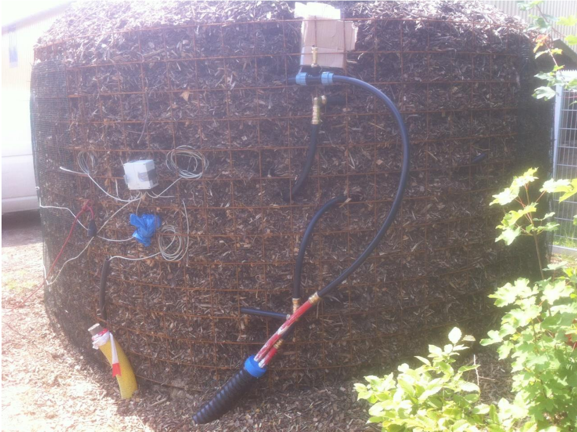
Der Anschluss der Leitung an den Biomeiler. Erste Elektronik ist zu sehen
