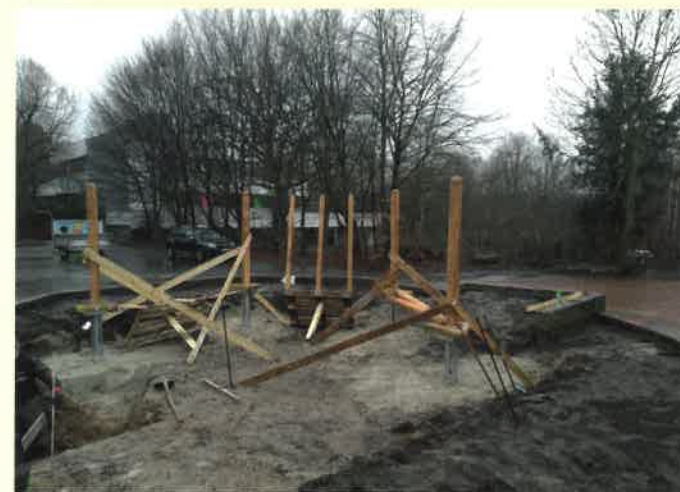
In der zweiten Januar-Woche wurde der „Active-Trail Niederseilparcours“ mit ergänzendem Sitz- und Balanceelement vom beauftragten Garten- und Landschaftsbauunternehmen auf dem Schulhof der Johannes-Vincke-Schule aufgebaut. Foto: Förderverein JoVIS/M. Beckmann
