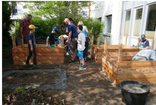
Ein Vater ist schon dabei im ersten Hochbeet Maschendraht zu befestigen. Hier ist gut zu sehen, dass der Boden, auf dem die Hochbeete stehen, zunächst ausgehoben wurde. Erst nachdem die Umrandung mit Splitt gefüllt war, konnten die Beete aufgestellt werden. Jedes Hochbeet wurde mit Folie ausgekleidet. Hier wird die Folie gerade zugeschnitten.
